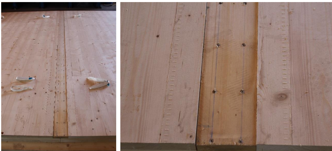
Figure 9 - Plancher CLT avec sa feuillure
