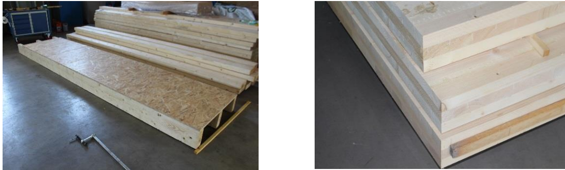
Figure 4 - Plancher traditionnel (à gauche) et plancher CLT (à droite)
